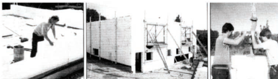
Рис. 11. Процесс заливки бетоном термоблоков и монтажа здания по системе "Термодом"
