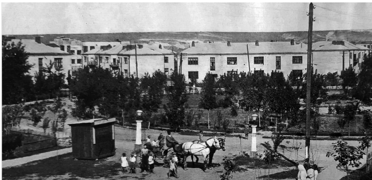
Рис. 4 – Забудова центральної частини селища «Жовтне» з круглим сквером. Загальний вигляд станом на сер. 1930-х рр. [9].
