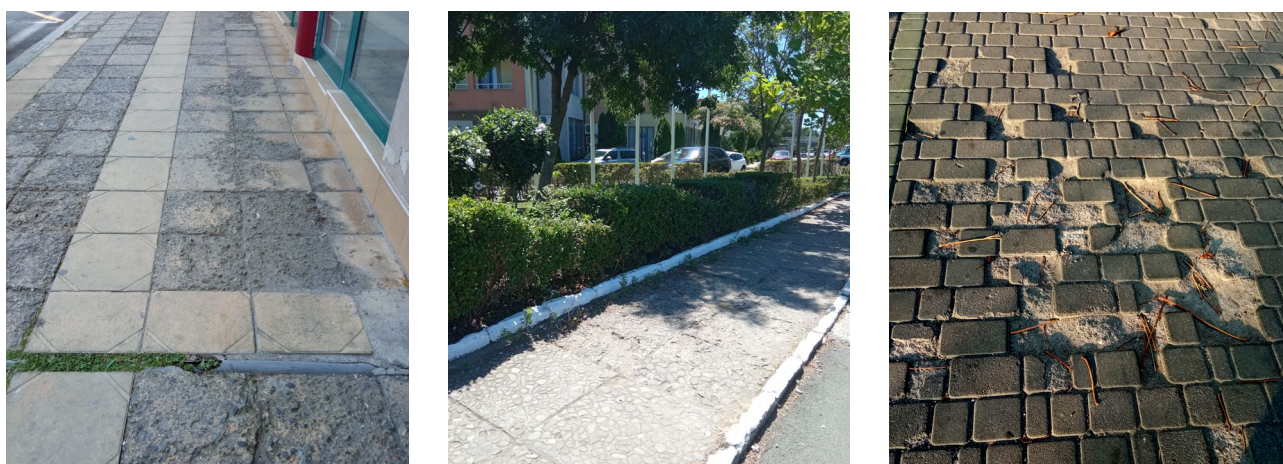
Рис. 2. Руйнування верхнього шару окремих елементів на вулицях Поморія (Болгарія), Сонячного берега (Болгарія) та Одеси (Україна)
